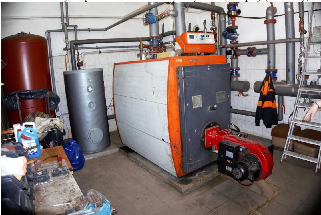
Zdjęcie 3. Widok kotłowni
